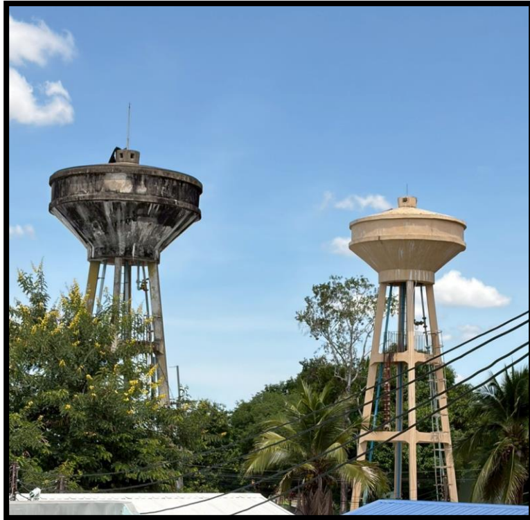
หอดังสูงน้ำประปา ติดตั้งระบบป้องกันฟ้าผ่าสิ่งปลูกสร้างแบบแท่งแฟรงกลิน (Franklin Rod)
